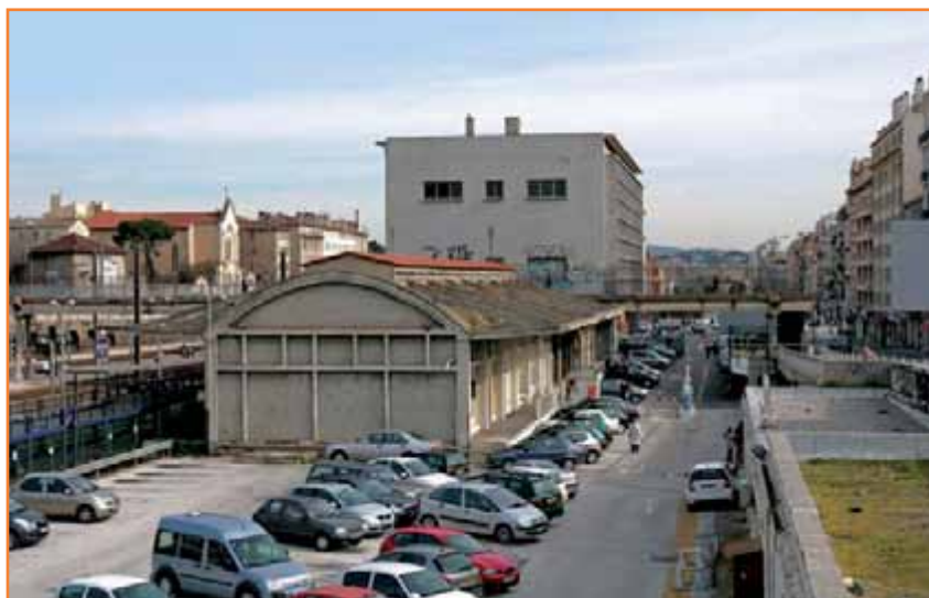
Le tri postal désaffecté laissera la place à un parking.
