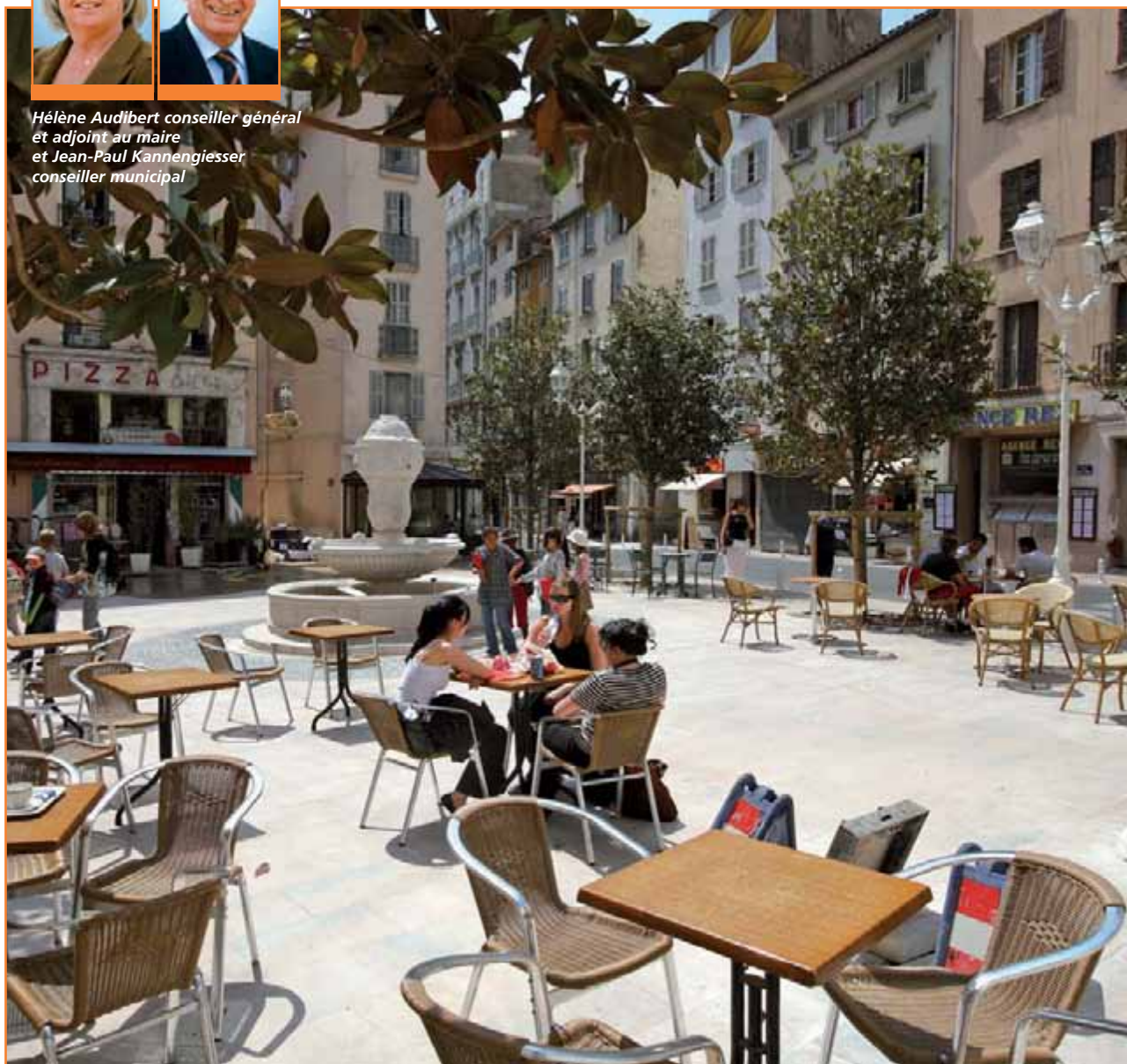
Les principaux espaces urbains du centre historique sont qualifiés: la place Senès...
