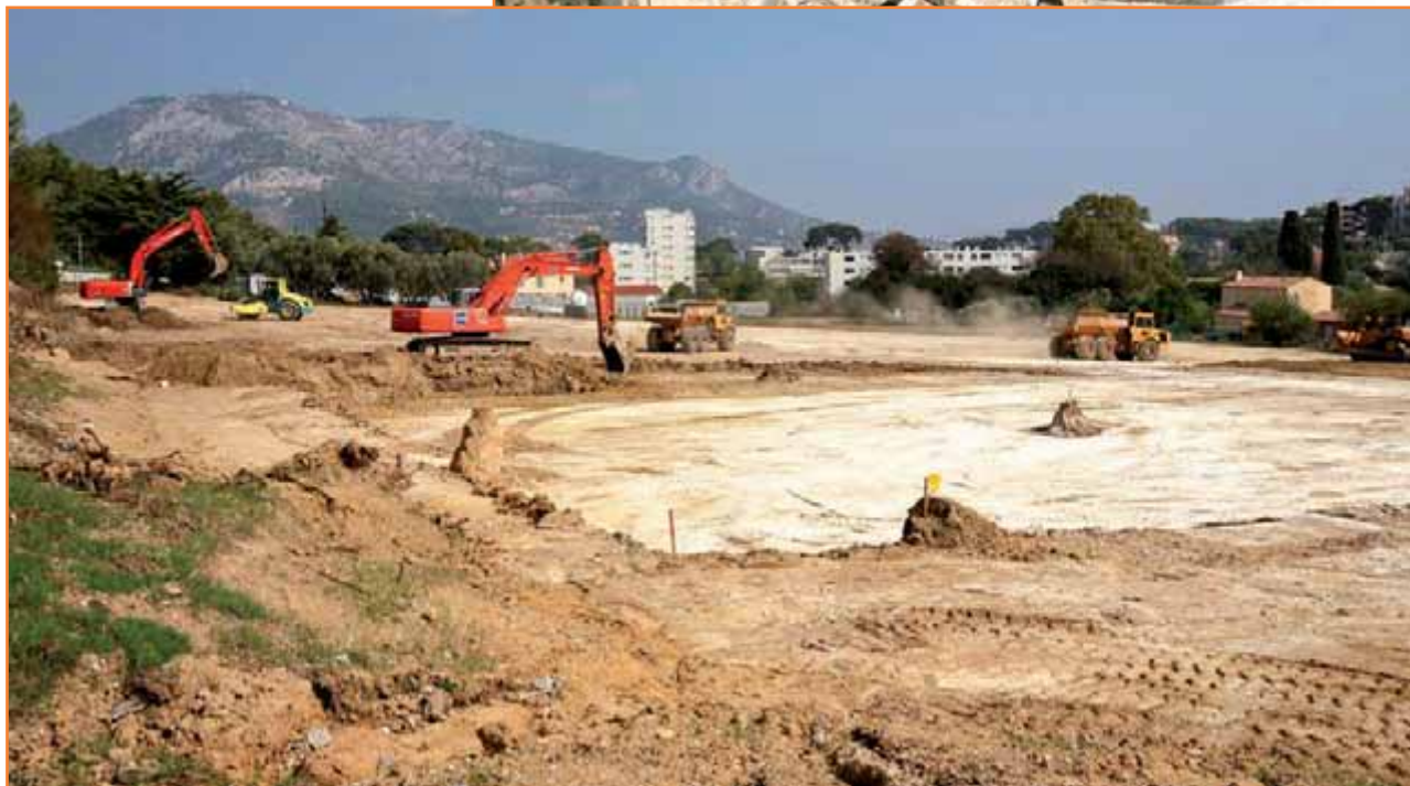
Le début des travaux: terrassement et réalisation d'un bassin de rétention.
