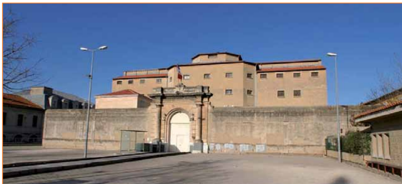
L'ancienne prison St-Roch sera démolie l'an prochain.
